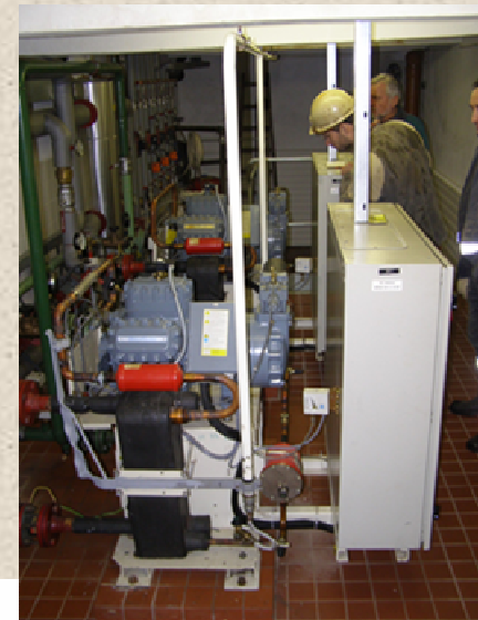
Tepelné čerpadlo jáma Svornost
